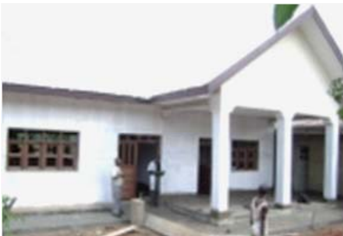
Maternité d'Aloya (NK) après réhabilitation (Photo UNFPA)
